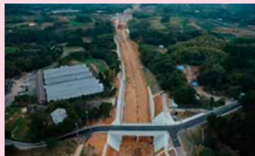
鹿児島3号赤瀬川地区改良工事
