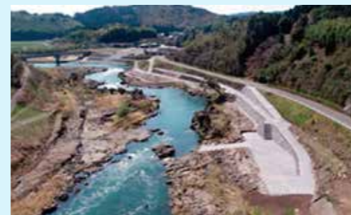
菱刈出張所管内環境整備工事
