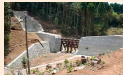
火山砂防工事(黒武者川工区)
