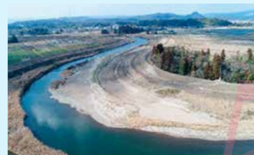
羽月川下流掘削工事
