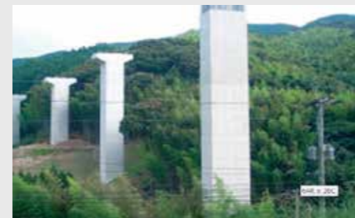
道路改築工事(泊野道路 18-2)
