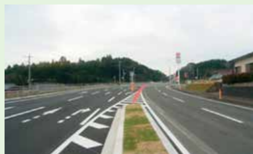
鹿児島3号 隈之城地区舗装工事
