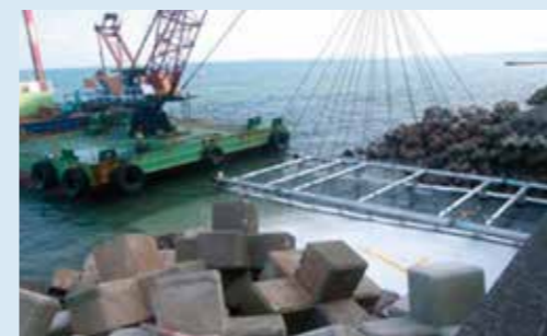
国道226号前之浜地区外防災工事
