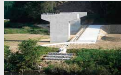
道路改築工事(広瀬道路 26-3)
