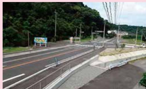
鹿児島3号土橋入口交差点整備工事
