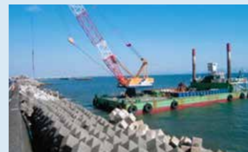
国道226号前之浜地区外防災工事
