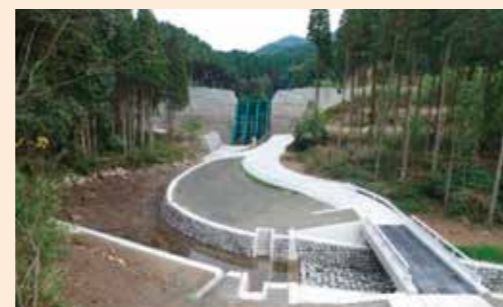
火山砂防工事(大馬越川(3)工区)
